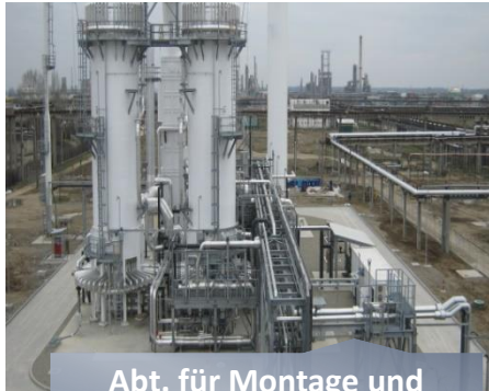
Abt. für Montage und Reparatur von Industrieanlagen
