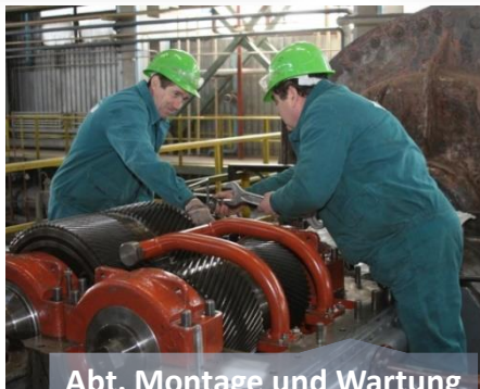
Abt. Montage und Wartung von dynamischen Ausrüstungen
