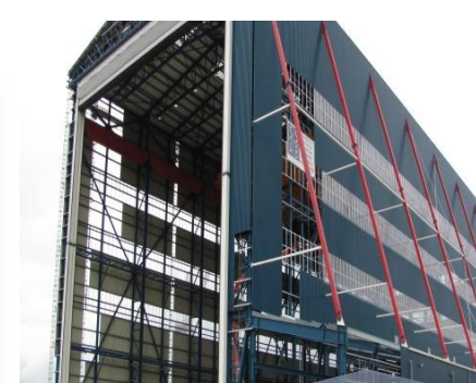
Departament Construcții civile
